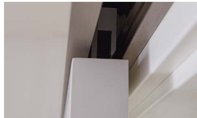
Befestigung einer Holztür im Schiebetürbeschlag Line
