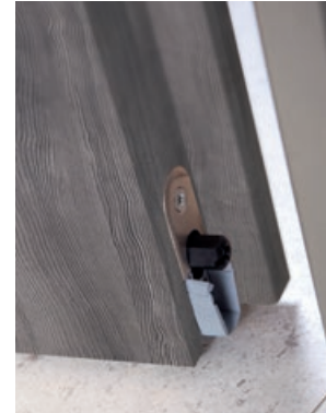
Standardausstattung bei Schallschutztüren: mechanisch absenkbare Bodendichtung
